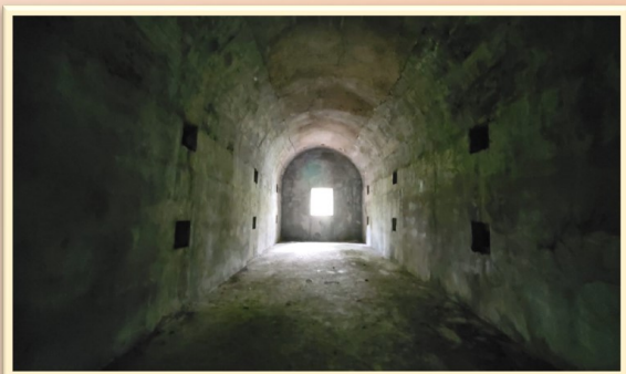
▲火藥洲火藥庫內部
